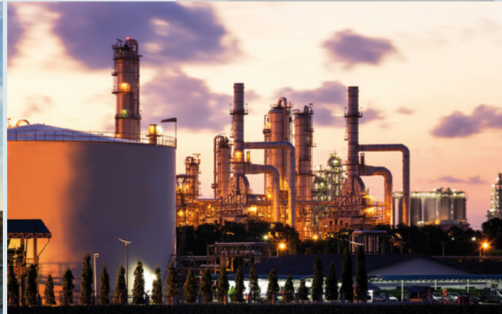
Chemie und Petrochemie
